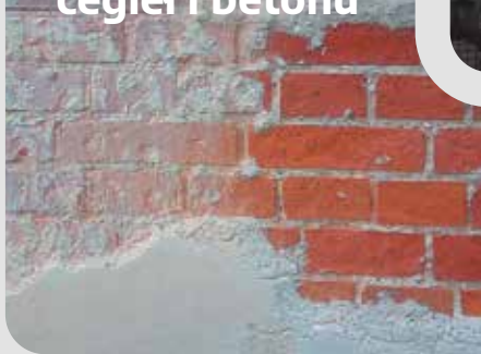
Piaskowanie cegły i betonu
